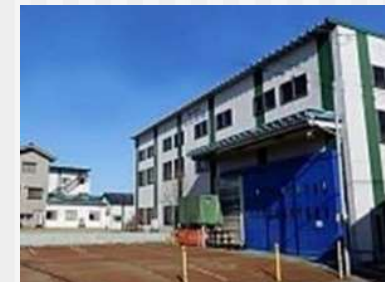
a) 設置電機工場の外観
