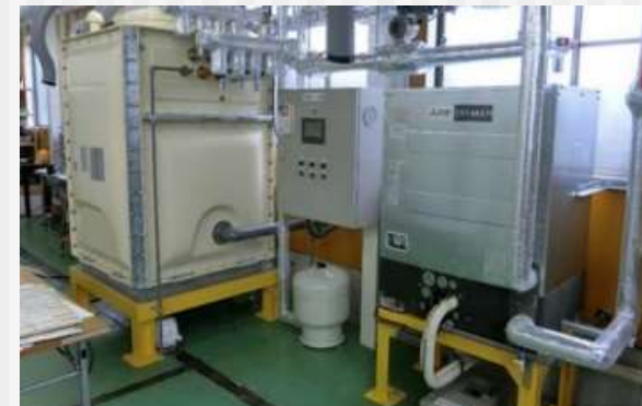
c) 空調用ヒートポンプとG-HEXを使った熱源機器
