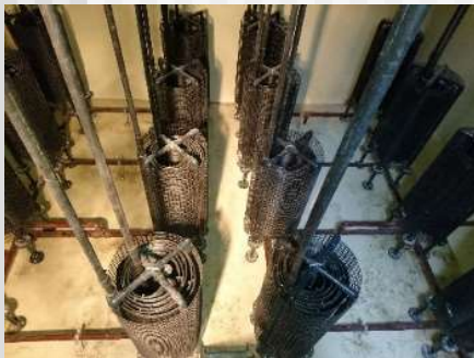
b) 曝気槽内に設置されたG-HEX
